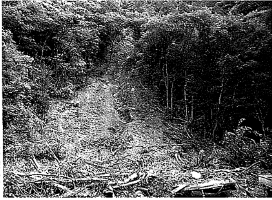
京都府南部豪雨で山腹が崩壊した現場(宇治市炭山) 府提供
